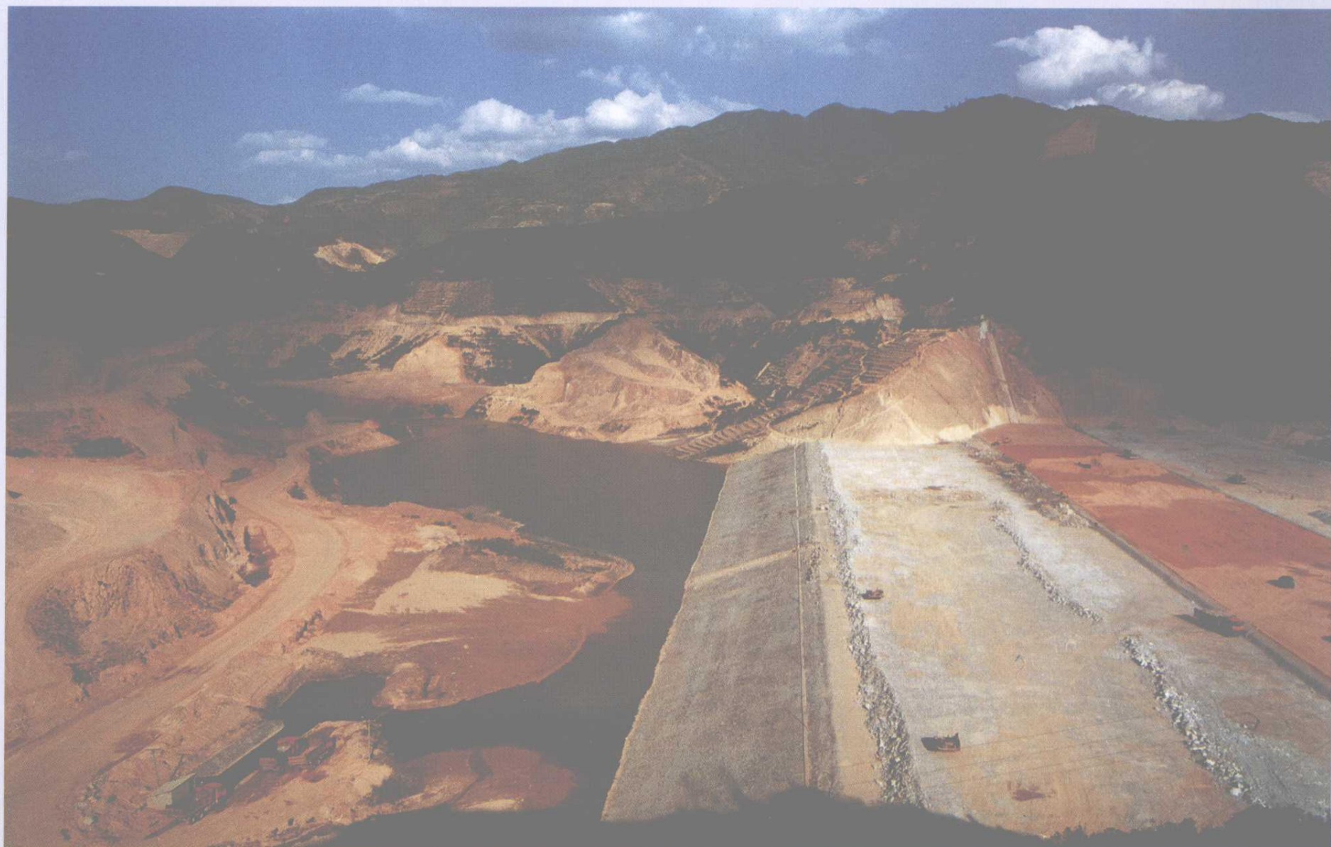
在建的中型水库刘家箐水库
