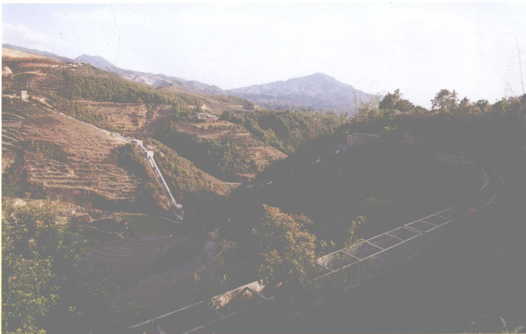
刘家箐水库倒虹吸及渡槽
