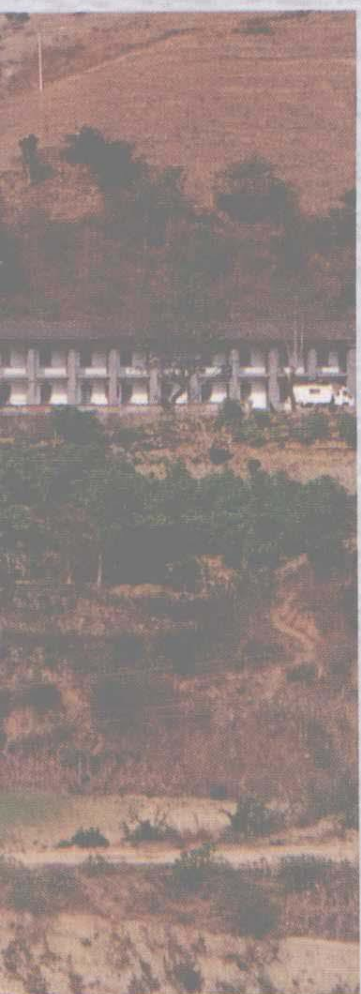
水电站——南河电站
