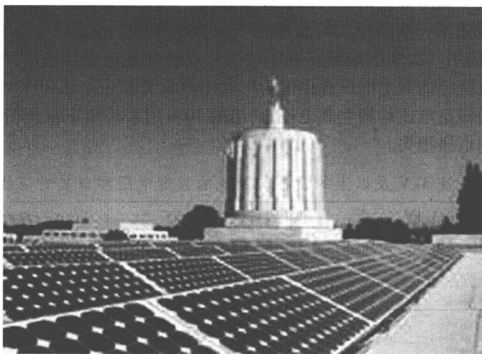
图 1-6 太阳能屋顶发电站
