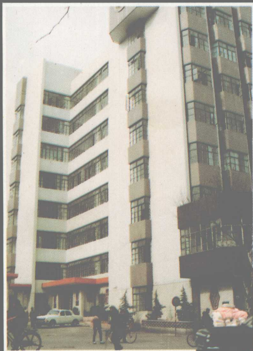
抚州供电大楼
