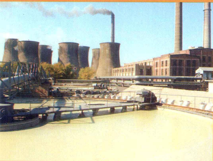
抚顺发电厂粉煤灰脱水装置
