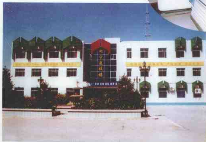
由福建省援建的同心县闽宁医技大楼和捐赠的医疗设备
