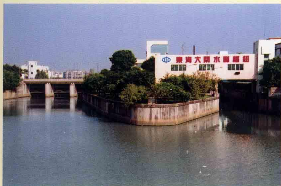
九江镇积水排放主出口——东海大闸水利枢纽
