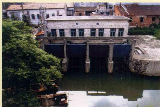
沙口机电排灌站
