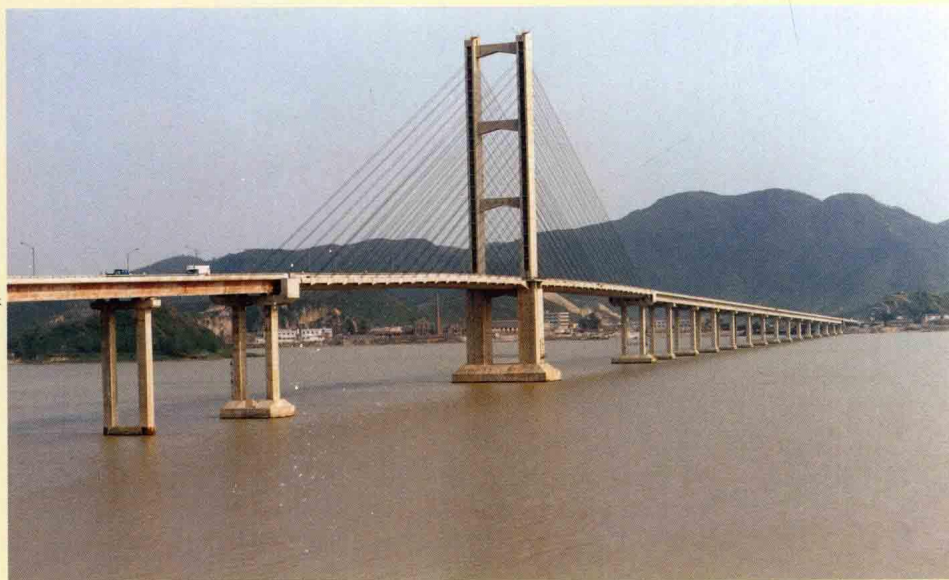
1988年6月12日，全国内地单孔跨度最大的独塔斜拉桥——九江大桥建成通车。
