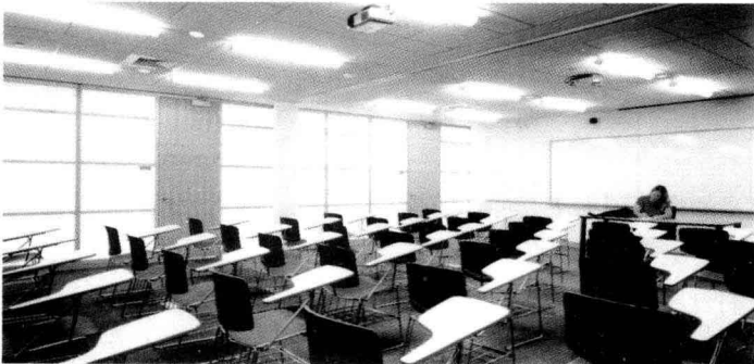
图 1-18: 未添加遮光罩的灯具容易产生直射眩光,在设计中应当尽量避免。
