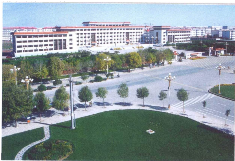
黄骅市委、市政府办公楼
