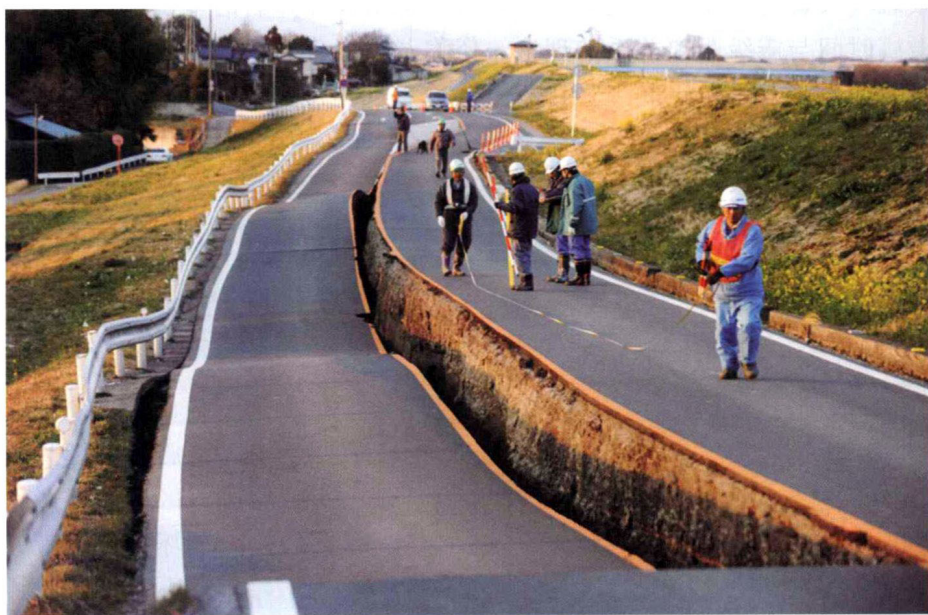
图 1-4 9.0 级地震发生后公路裂开、塌陷和扭曲
