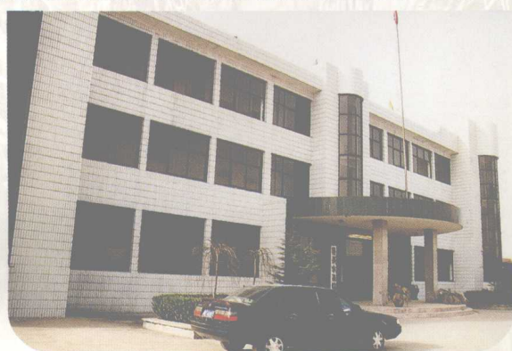
水务局办公楼
