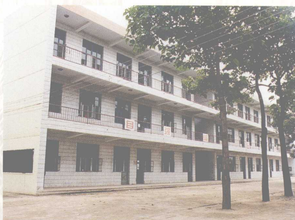
县中学教学楼
