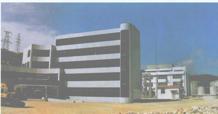
装机容量4万千瓦的柴油发电厂
