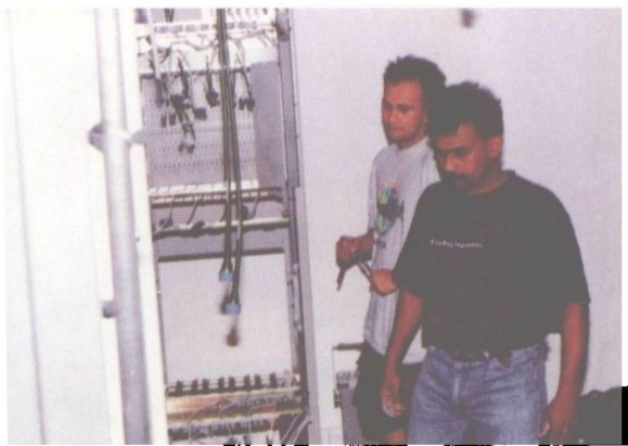
▲外国专家在钦州移动电话基站施工。
