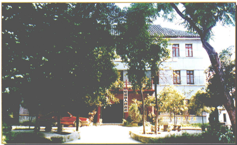
望谟县人民政府办公楼
