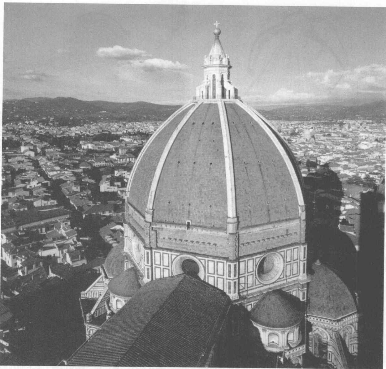
图13.4 菲利波·布鲁内莱斯基，佛罗伦萨大教堂穹顶，公元1420—1436年。天窗灯笼式屋顶完成于1471年。布鲁内莱斯基没有使用临时性脚手架，就成功地建造了这个巨大的双层尖顶穹顶。它是佛罗伦萨的主要标志。
