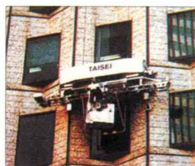
机器人清洁墙壁
