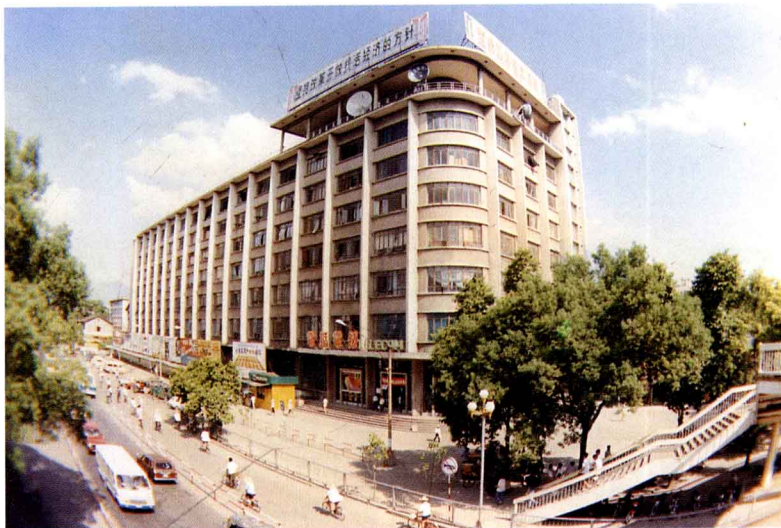
1964年建成的东街口邮电综合大楼，楼高34.8米，总面积16728平方米，成为六七十年代福州市标志性建筑。当时“福州电信局”设于三楼。
