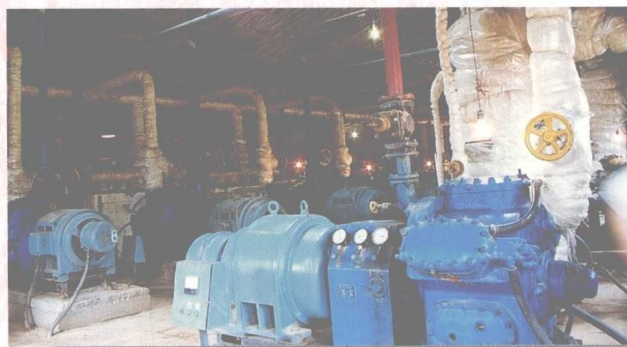
▲ 中煤特蓄处冻结施工工艺
