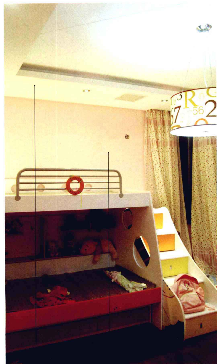
局部石膏板吊顶
