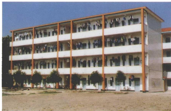
宽敞明亮设施齐全的学生宿舍楼
