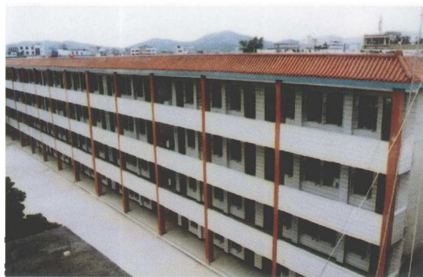
1999年加固装饰后的教学大楼
