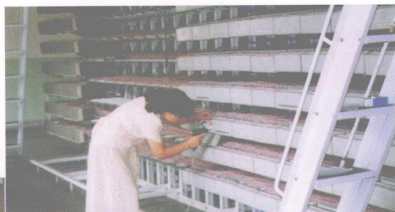
1.4万门程控 电话机房（测量）
