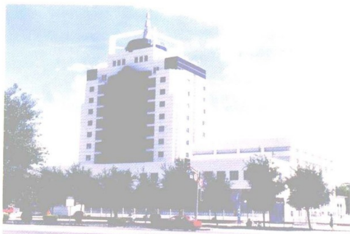
包头电视大楼
