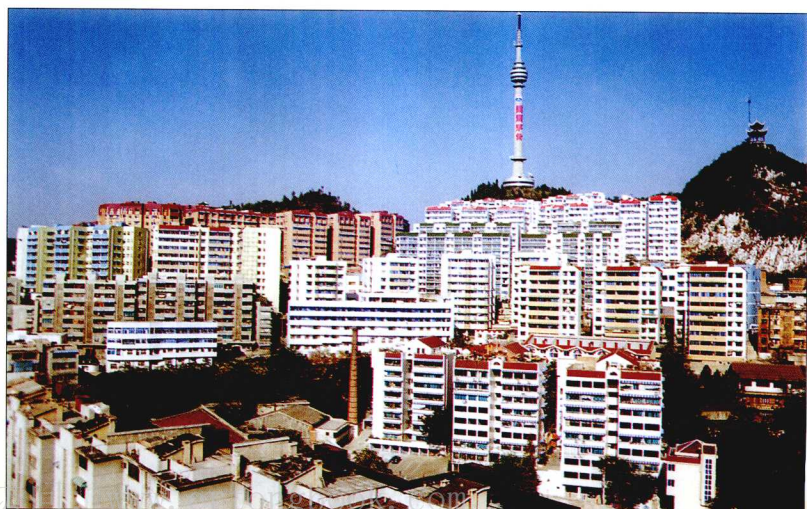
建设银行贵阳市分行贷款支持的“栖霞小区”安居工程
