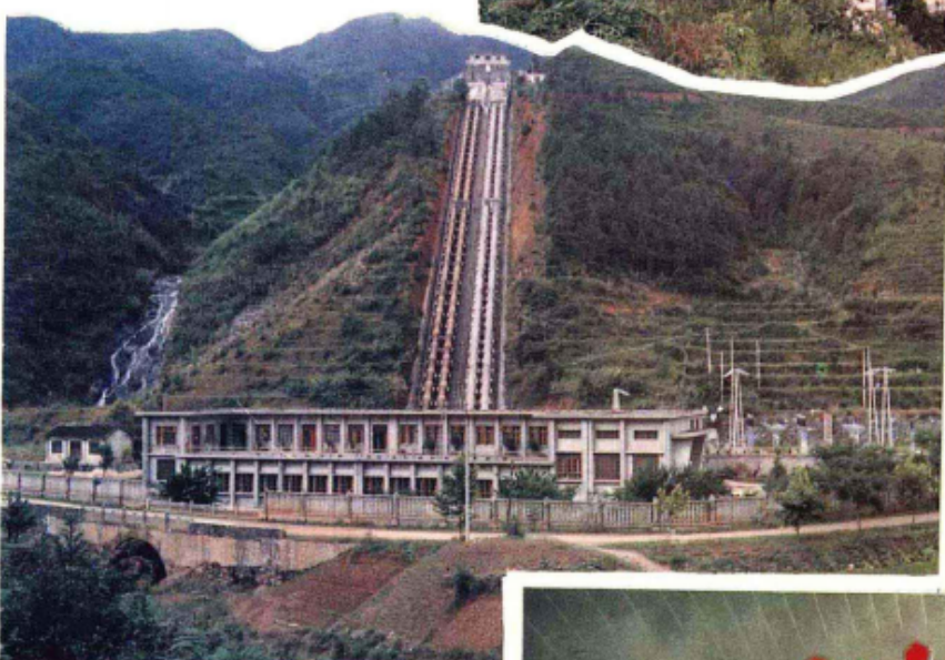
港口三级水电站
