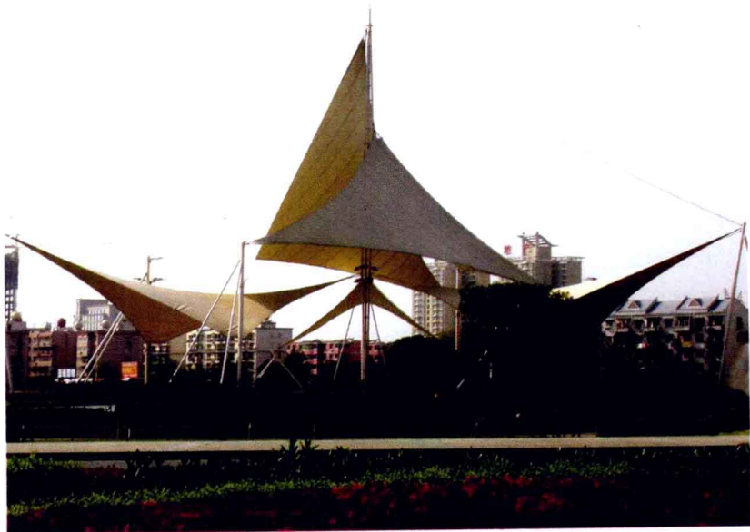
图 1-5 拉膜建筑已广泛运用于室外环境
