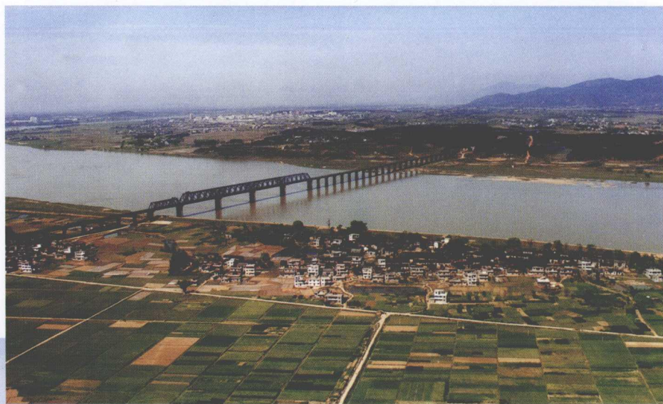
赣江京九铁路大桥
