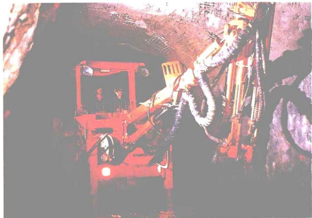
开阳县磷矿矿井建设
