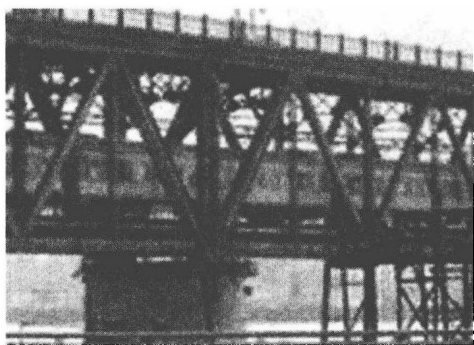
图 1-9 杭州钱塘江大桥
