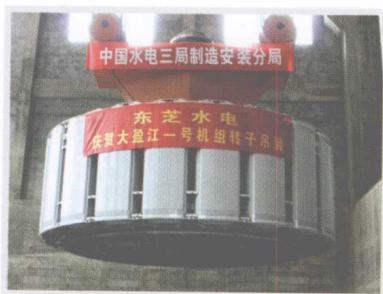
大盈江电站转子现场吊装
