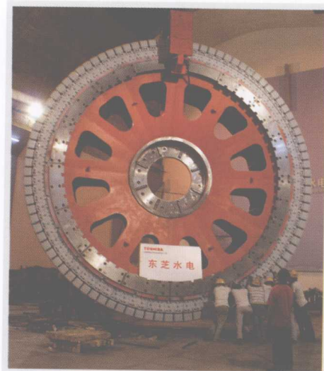
清水塘电站转子现场吊装
