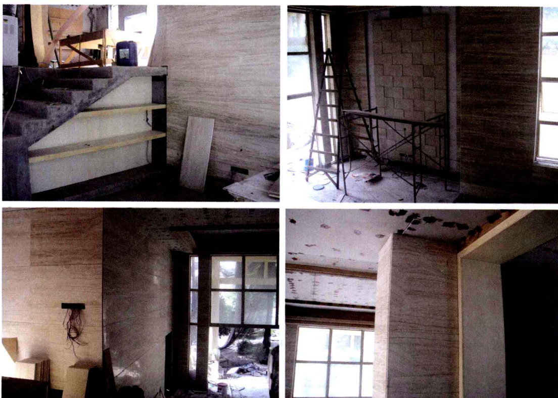
图 1-12 施工现场图片 (1) 文健 摄
