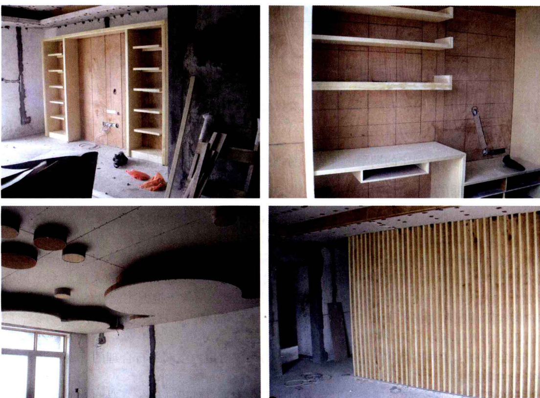
图 1-13 施工现场图片 (2) 文健 摄
