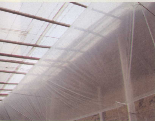
日光温室通风口处设置挡风膜
