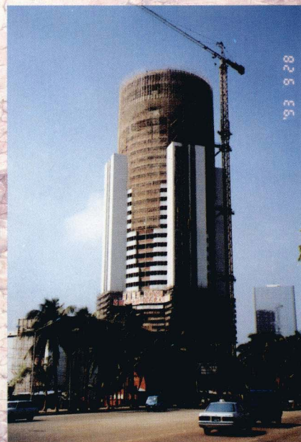
海口市金貿區“石化大廈”
