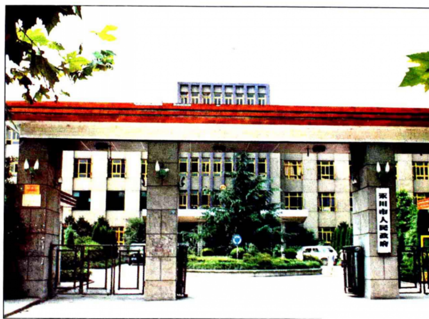
►永川市人民政府大楼
