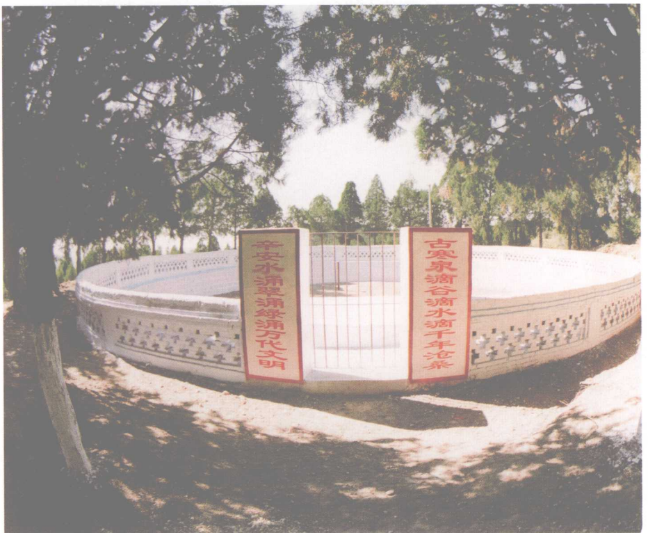
老顶山饮水蓄水池
