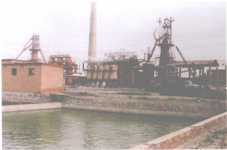
郊区铁厂外景
