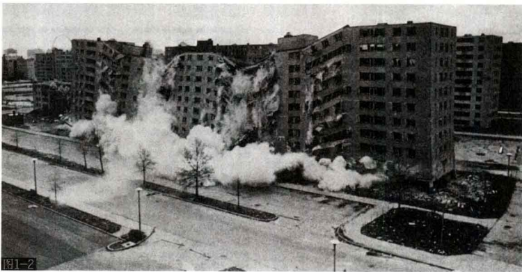
图1-2 被炸毁的帕鲁伊特·伊戈住宅区高层板式公寓
