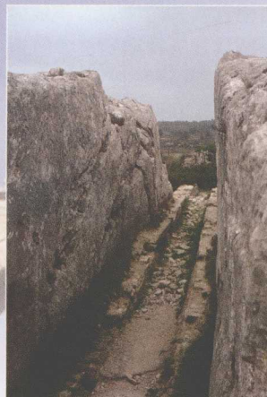
高架渠中的水从一个深槽中流过。
