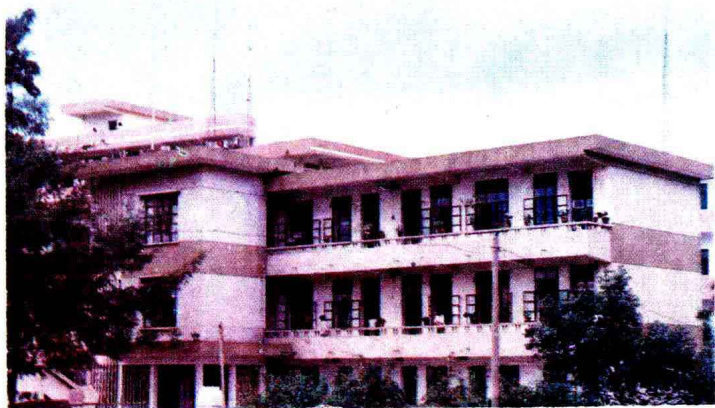
县卫生职工中专学校教学楼。
