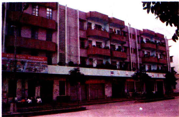
廉江县保险公司办公大楼外貌。
