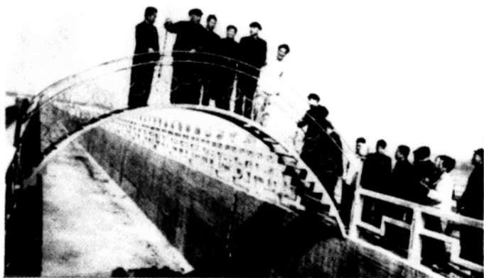
1963年1月陈华荣陪同朱德委员长视察东海河大渡槽合影。站在桥上的从左至右陈华荣、朱德、随员、谢永宽、凌俊卿、随员。
