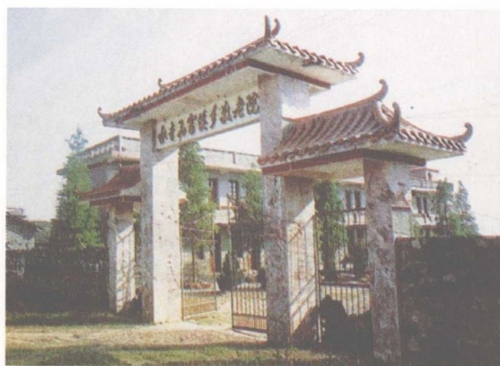
永丰县富溪乡敬老院
