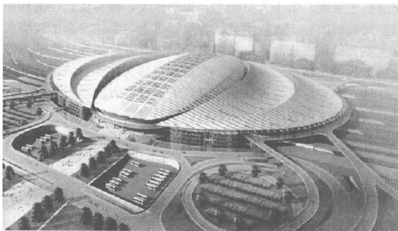
图 1-1-1 北京南站多层地下综合交通枢纽
