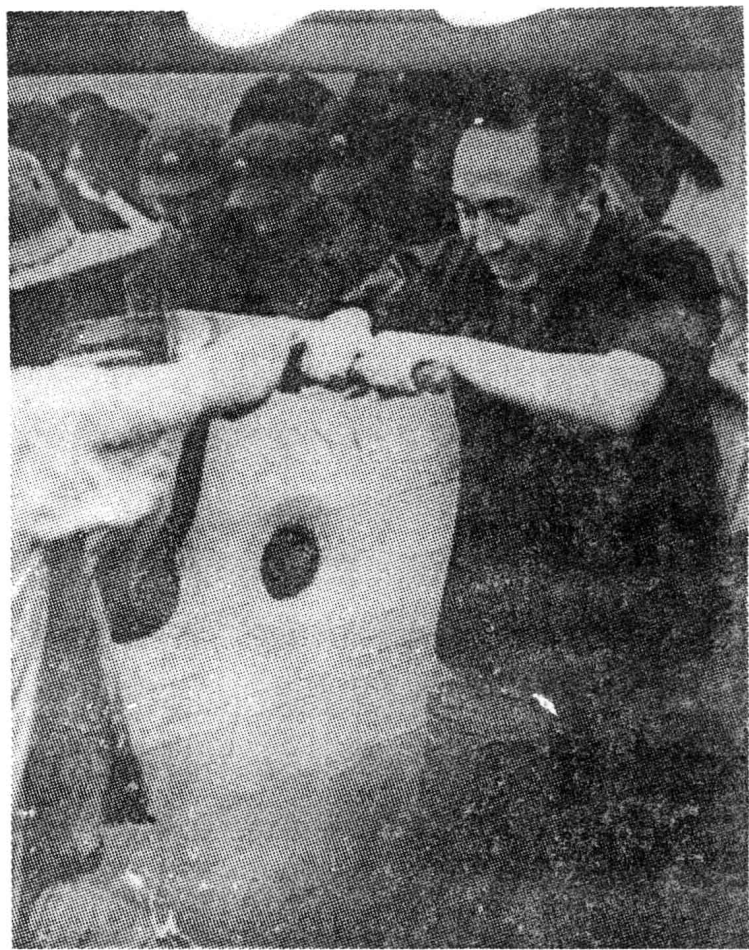
原中共湛江地委第一书记孟宪德同志启动输水闸门放水
