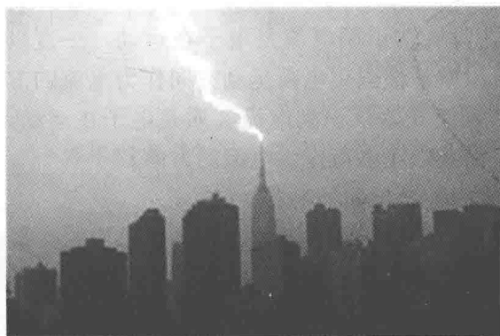
图 1-9 避雷针的防雷作用
