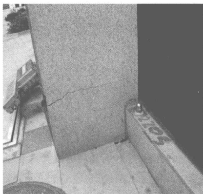
图 4 建筑物裂缝
