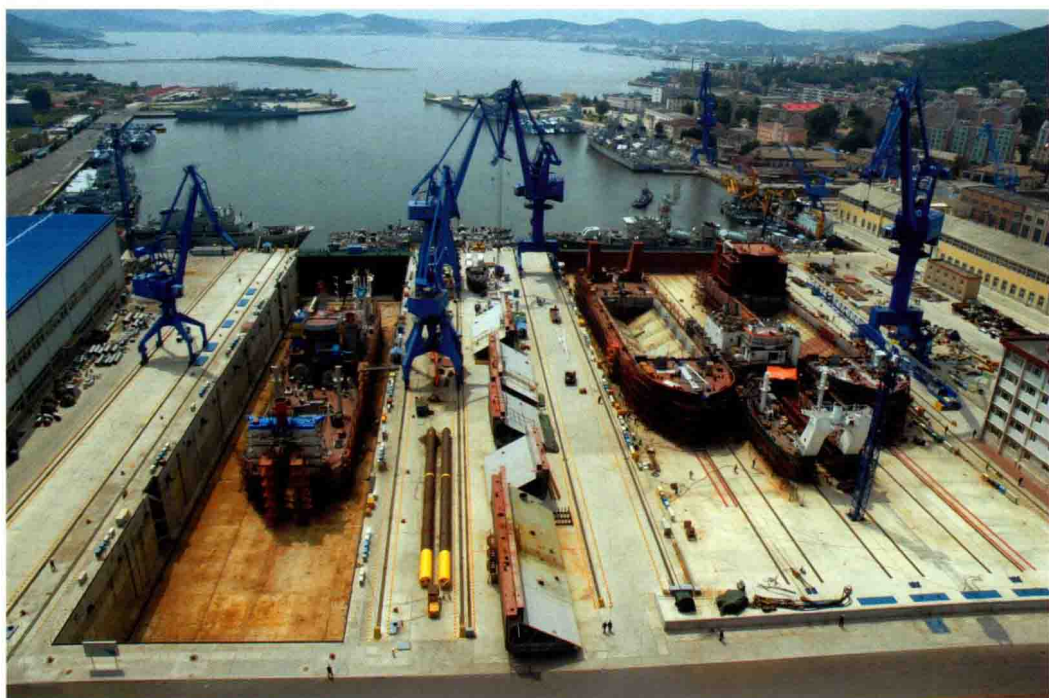
工厂新建 2.4 万吨级船坞与万吨级半潜式连体船台
