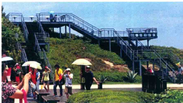
图1-2-13 架空的径、路、平台延伸称栈道（野柳）
