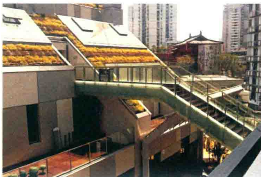
图1-2-10 联系不同标高的建筑层次（世博园西安馆）
