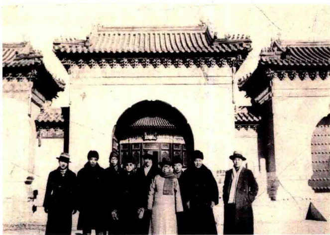
天坛皇穹宇修缮竣工验收琉璃门前合影（右一为杨廷宝）（来源：江苏省档案馆，拍摄时间：1935年12月）
