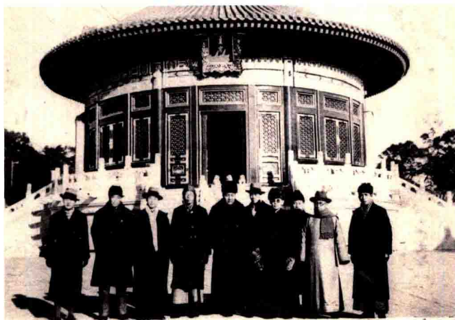
天坛皇穹宇修缮竣工验收合影（左三为杨廷宝）（来源：江苏省档案馆，拍摄时间：1935年12月）
