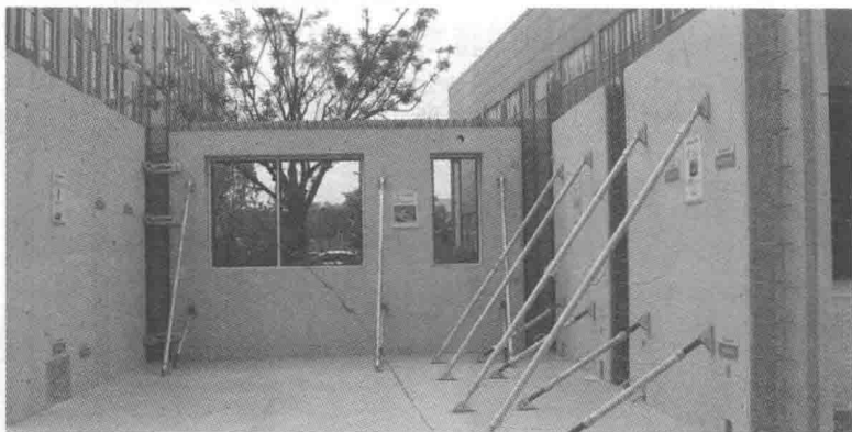
图 1-13 装配整体式混凝土剪力墙结构
