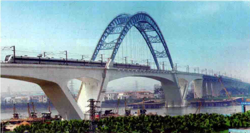
广州小榄特大桥属于新建铁路广州至珠海城际快速轨道交通工程，充分体现了高强、整体、大跨及新结构的综合建桥技术，在施工中创造了许多新技术、新工艺。此桥于2009年建成通车
