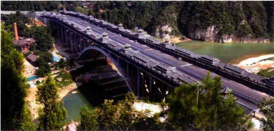
凯里清水江风雨桥，是目前世界上最长最宽的风雨桥，大桥的主体工程由贵州路桥集团承建，已于2013年9月全面建成通车
