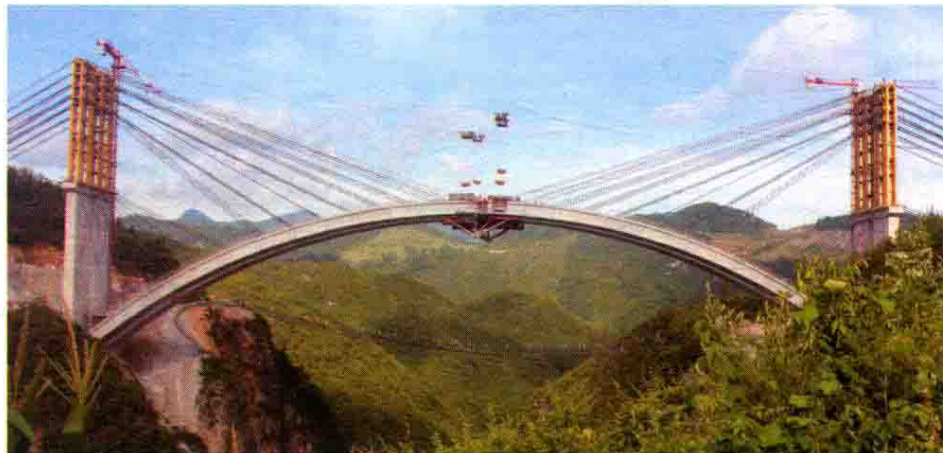
思剑高速公路木蓬特大桥，突破了传统拱桥施工工艺的跨径瓶颈，木蓬特大桥其扣、锚索一次张拉控制和斜爬施工挂篮等为国内首次采用。此桥于 2012 年 7 月 5 日顺利合龙
