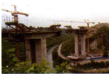
建设中的惠罗项目歪刀链江大桥
