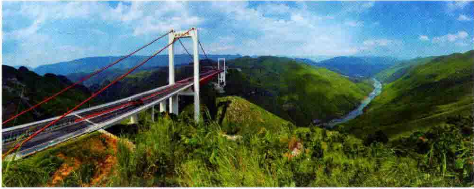
镇胜高速公路北盘江特大桥，建成时为全国最大跨度钢桁加劲梁悬索桥。大桥于2008年11月28日建成通车
