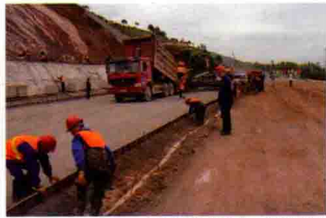
惠罗项目紧锣密鼓施工中
