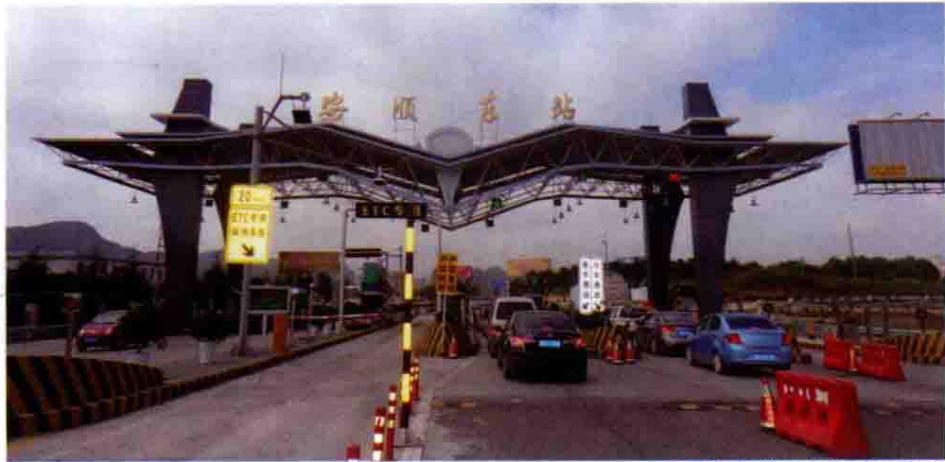
安顺东收费站以扩建后全景
