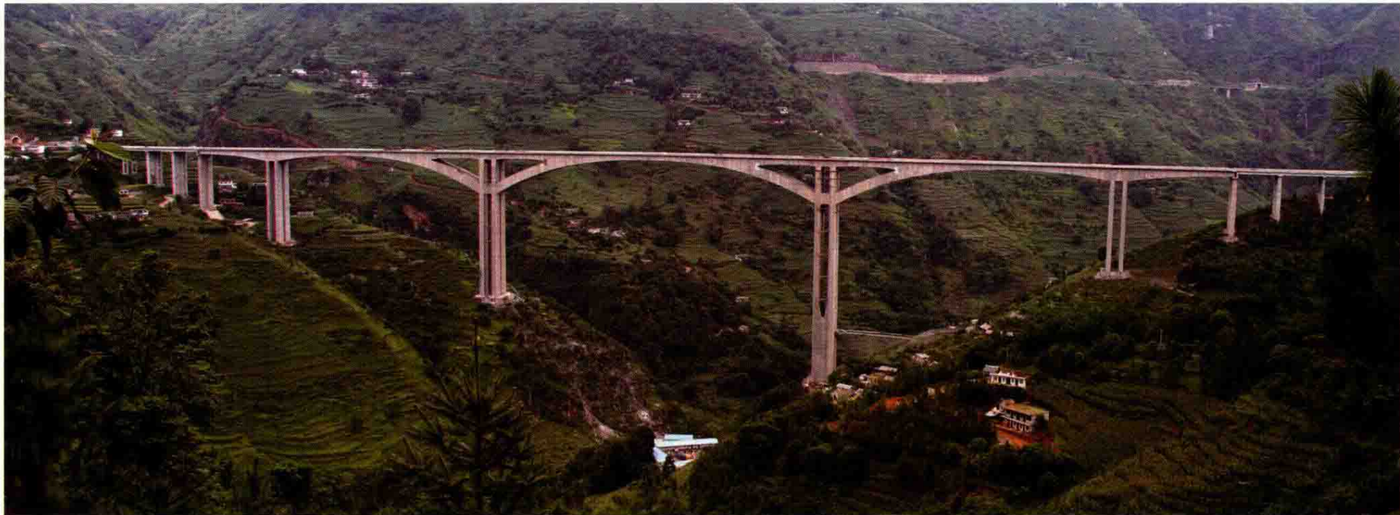
水盘高速公路北盘江特大桥，是目前亚洲最大跨度的预应力混凝土连续刚构桥，也是世界上最大的预应力混凝土空腹式连续刚构。大桥于 2013 年 8 月建成通车
