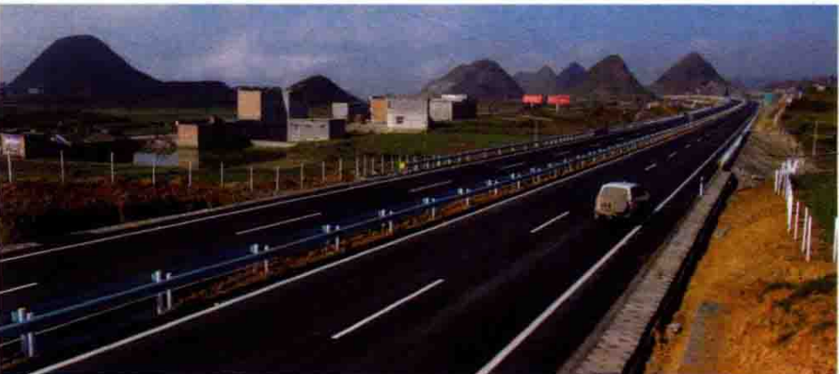
2012 年 12 月 31 日，惠水至兴仁高速公路贞丰黄腊田至兴仁段通车试运行
