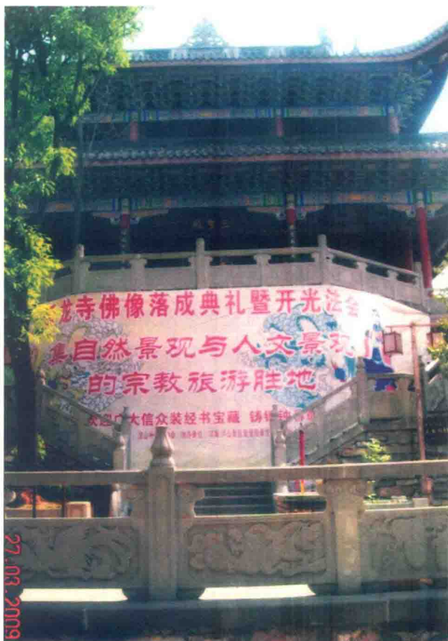
照片 1 经历过 1850 年地震的青龙寺古建筑
