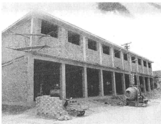
图 1.6 砖混结构
