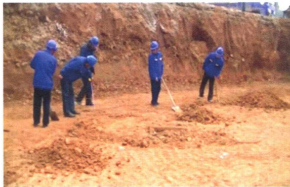
图 2-6 拉线清槽保证基地标高，将虚土全部清掉
