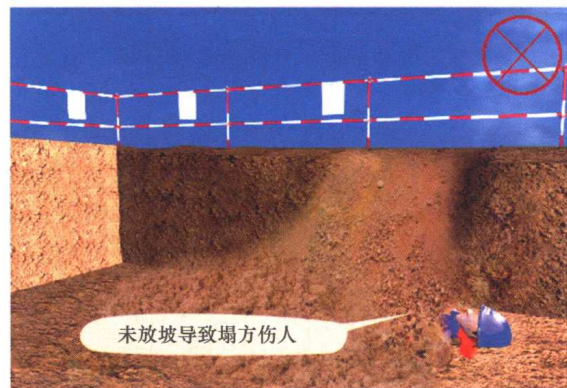
图2-1 未适当放坡导致塌方伤人
