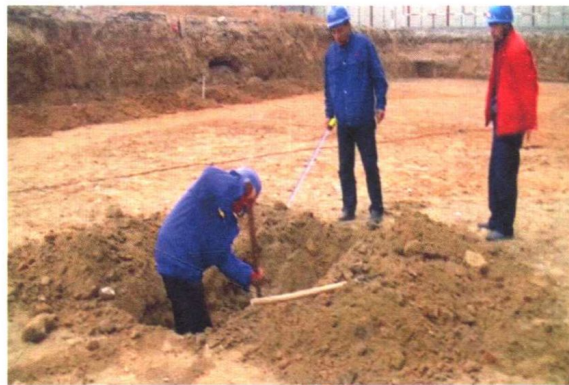
图 2-4 未挖到原土的部位，通过挖探坑掌握应挖深度
