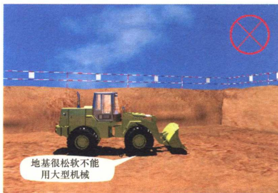
图 2-3 地基较松软时不得扰动地基
